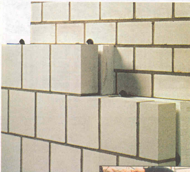
Двухслойная стена с воздушной прослойкой между внутренней и наружной оболочками.
