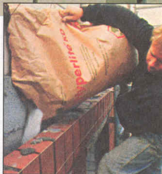
Двухслойная стена с воздушной прослойкой между внутренней и наружной оболочками.
