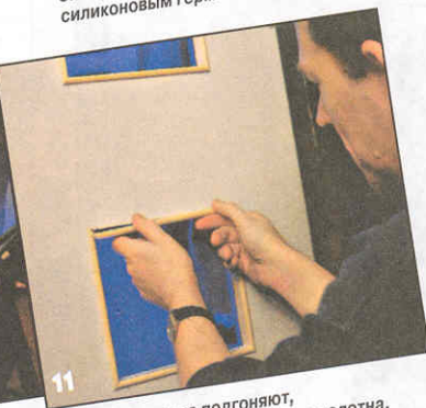
11 Штапики сначала подгоняют, затем лакируют в тон дверного полотна. Итак, старая дверь не просто отремонтирована, но приобрела совершенно новый дизайн.
